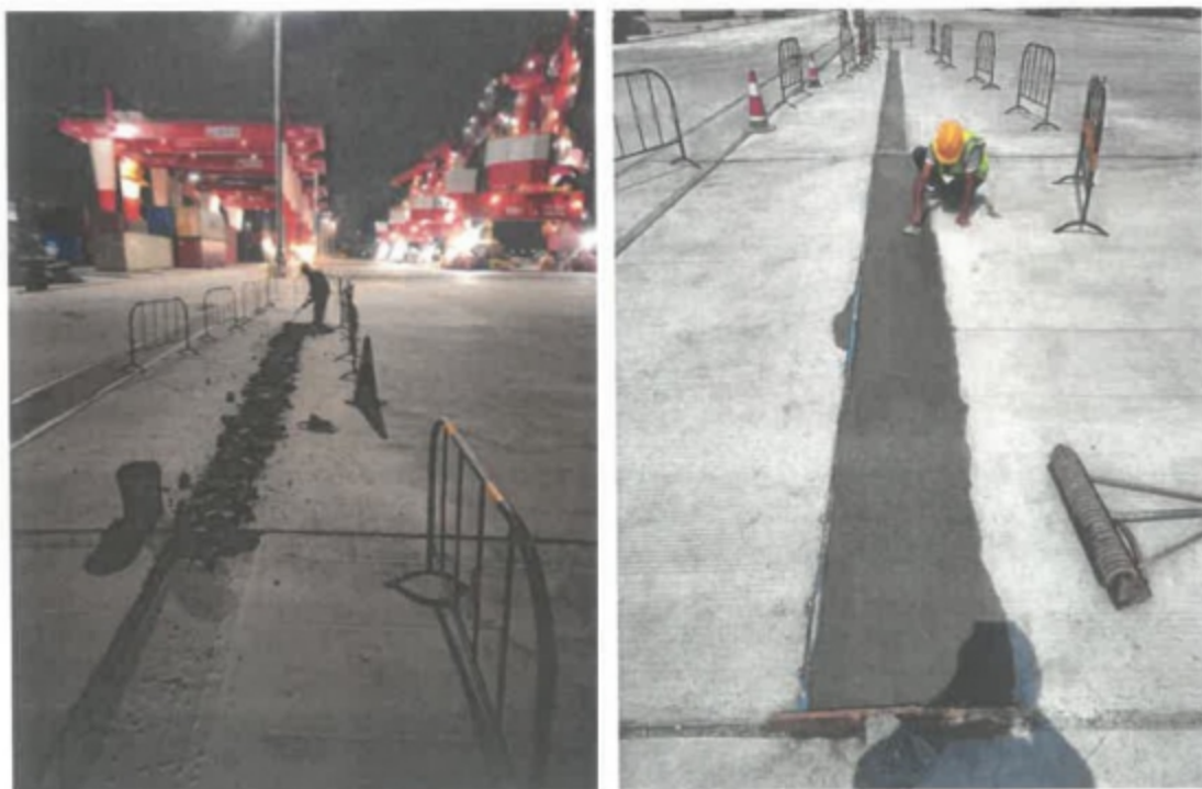
凿除开裂部位重新浇筑混凝土
