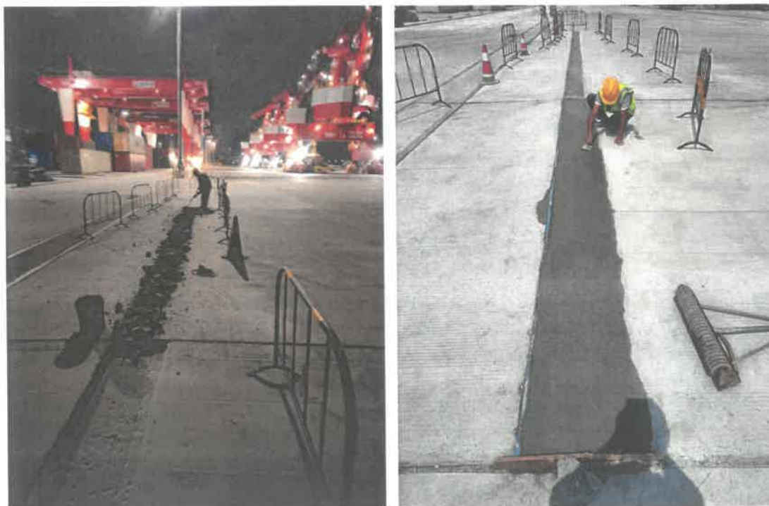
凿除开裂部位重新浇筑混凝土
