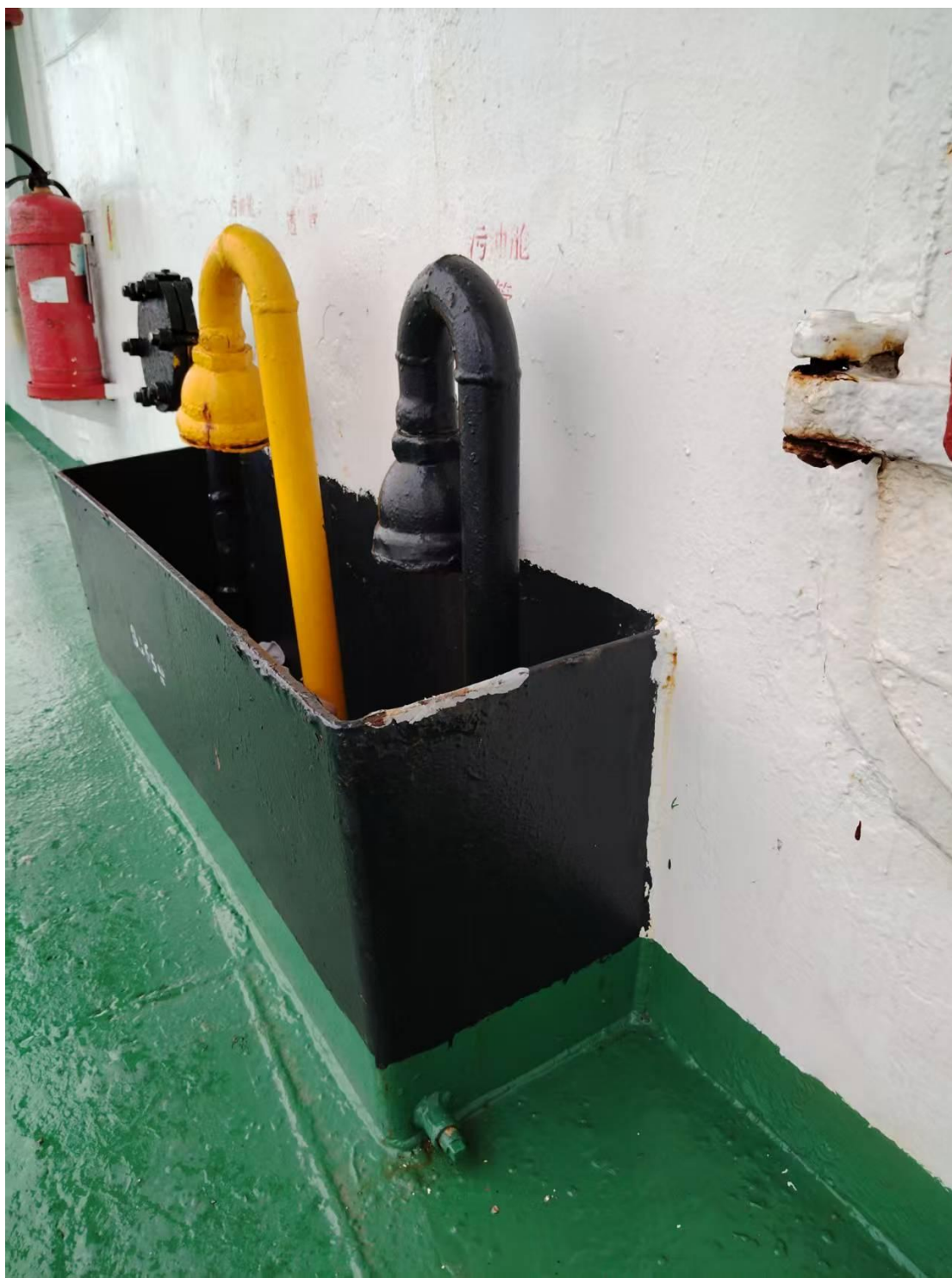
集油槽进行堵塞
