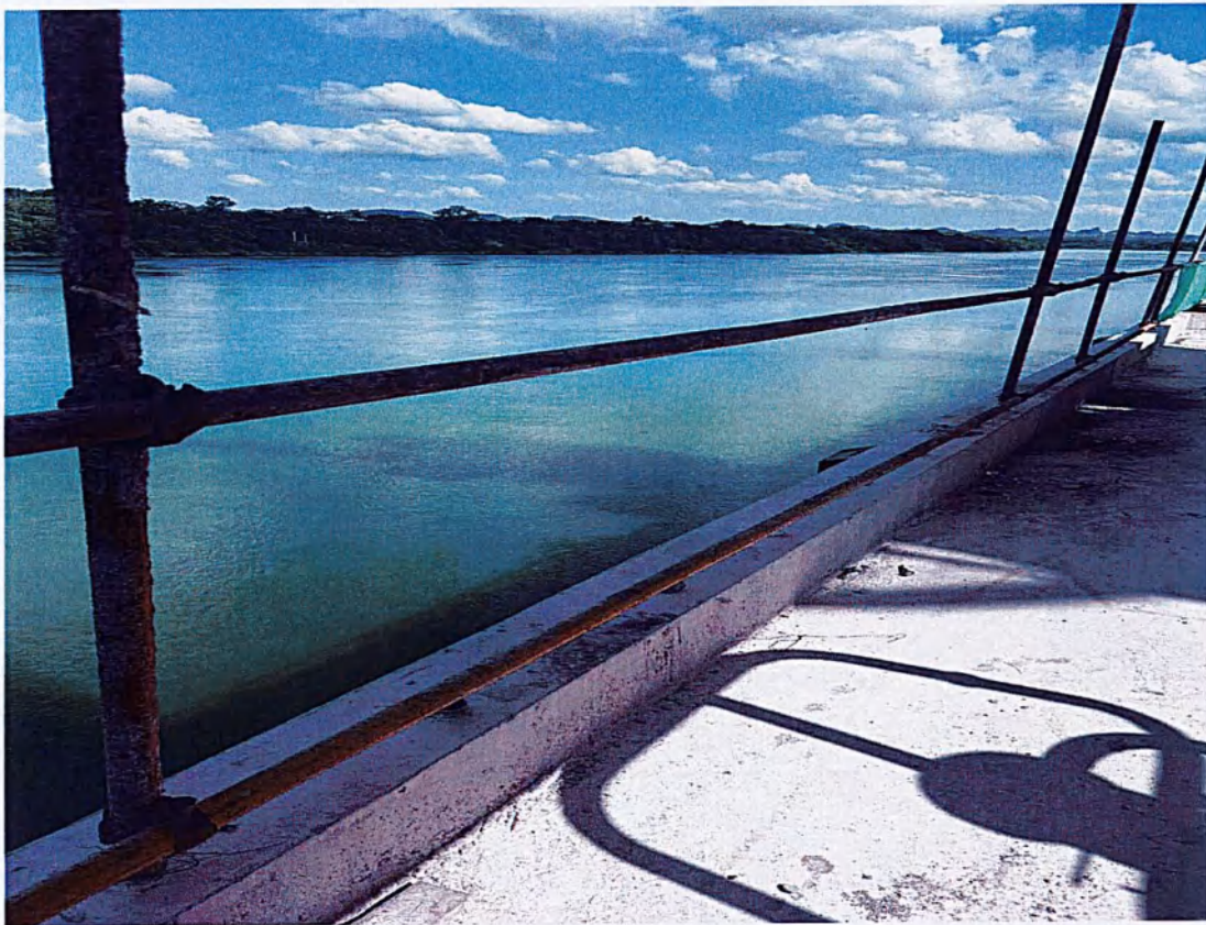
整改后照片：3号、4号泊位边沿临时防护栏已增设立杆间距为2米
