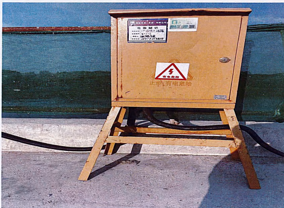
整改前照片：板面二级配电箱旁无灭火器
