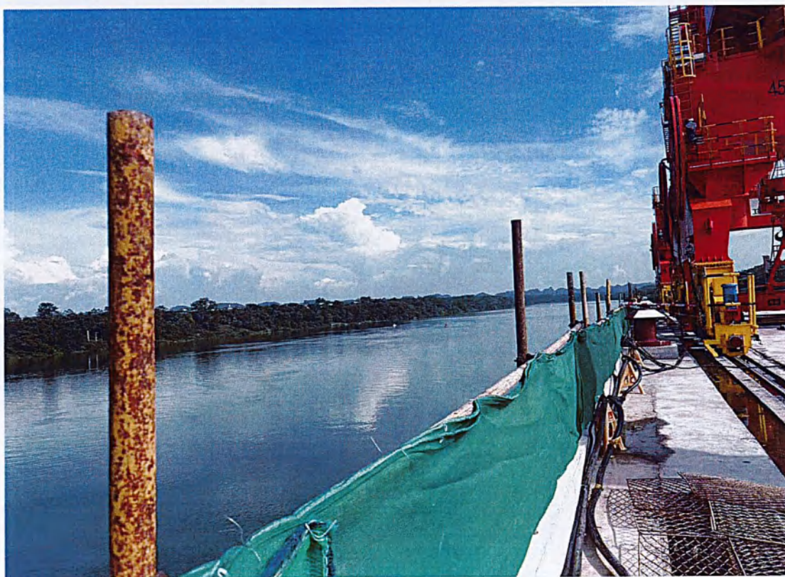
整改后照片：3号、4号泊位边沿临时防护栏已增设立杆间距为2米
