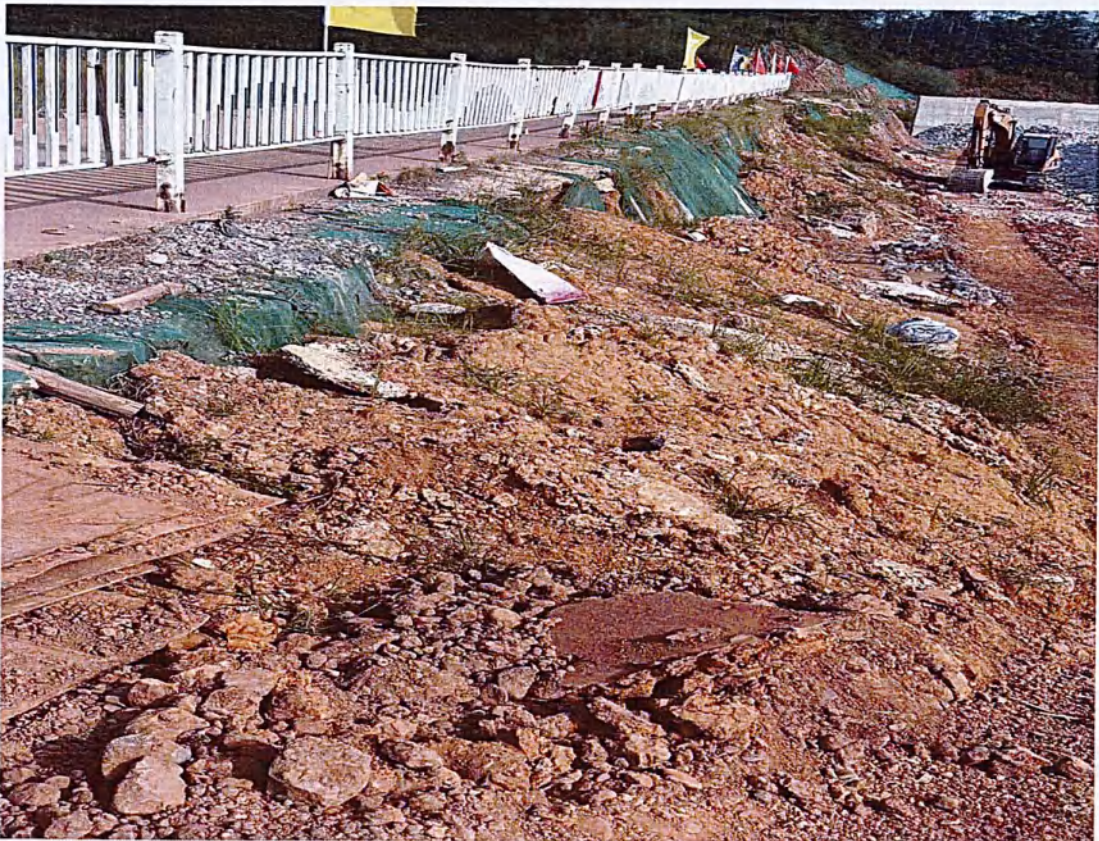
整改前照片：局部已形成的边坡缺乏防护措施，存在水土流失现象。
