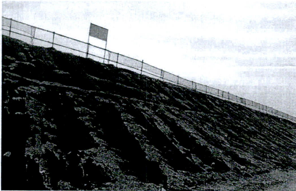
照片 2：上引航道水土保持临时防护
